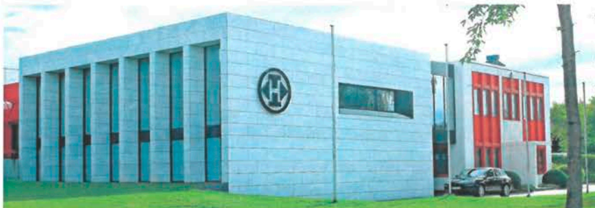
Das Technologieunternehmen Thermik Gerätebau gibt den Standort im Pforzheimer Altgefäll auf. Im Vordergrund der Neubau des Kompetenzzentrums.
